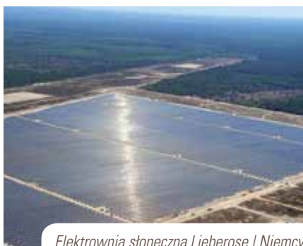
Elektrownia słoneczna Lieberose | Niemcy
